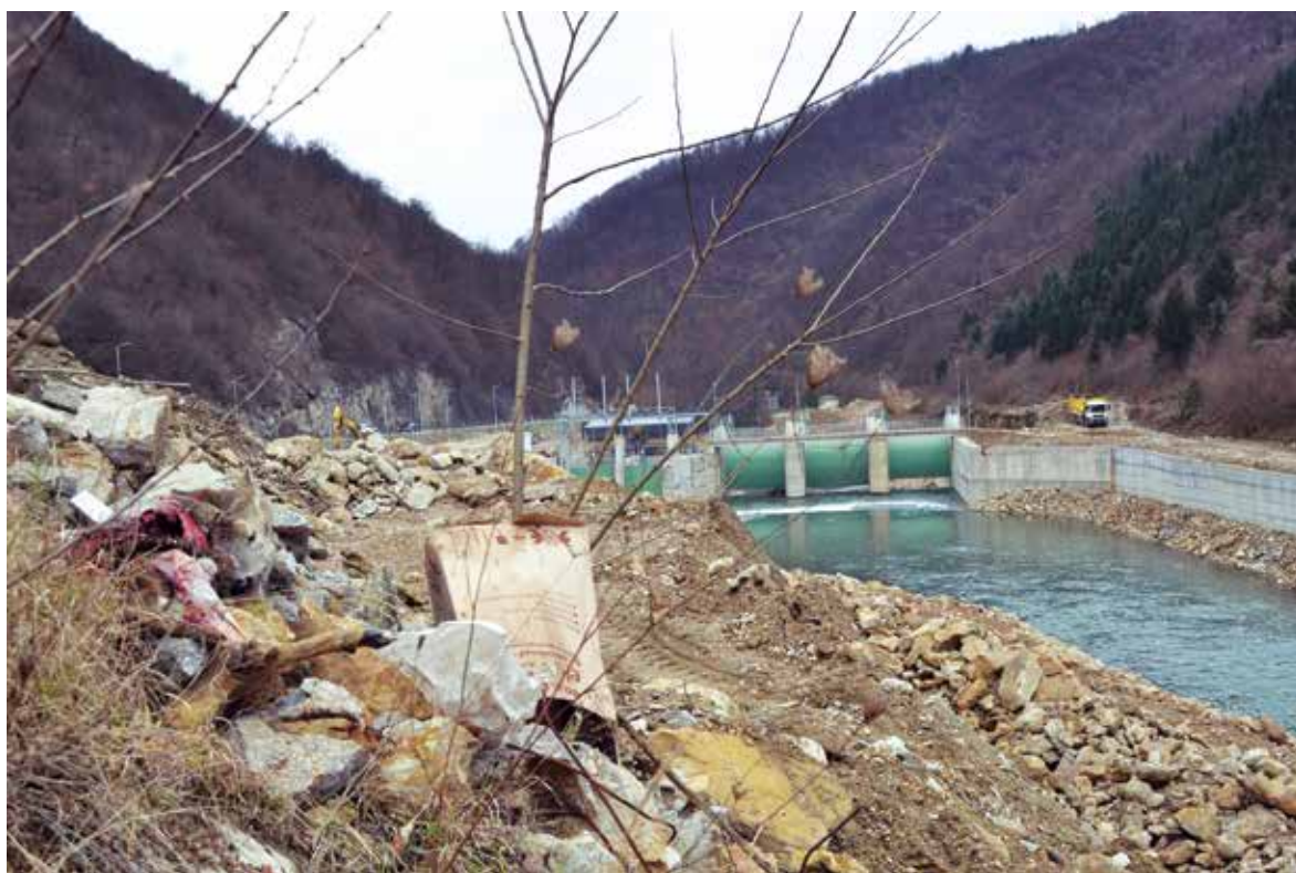
11. Mrtva srna na akumulaciji MHE Merdani, rijeka Lašva, Busovača 14.12.2020
